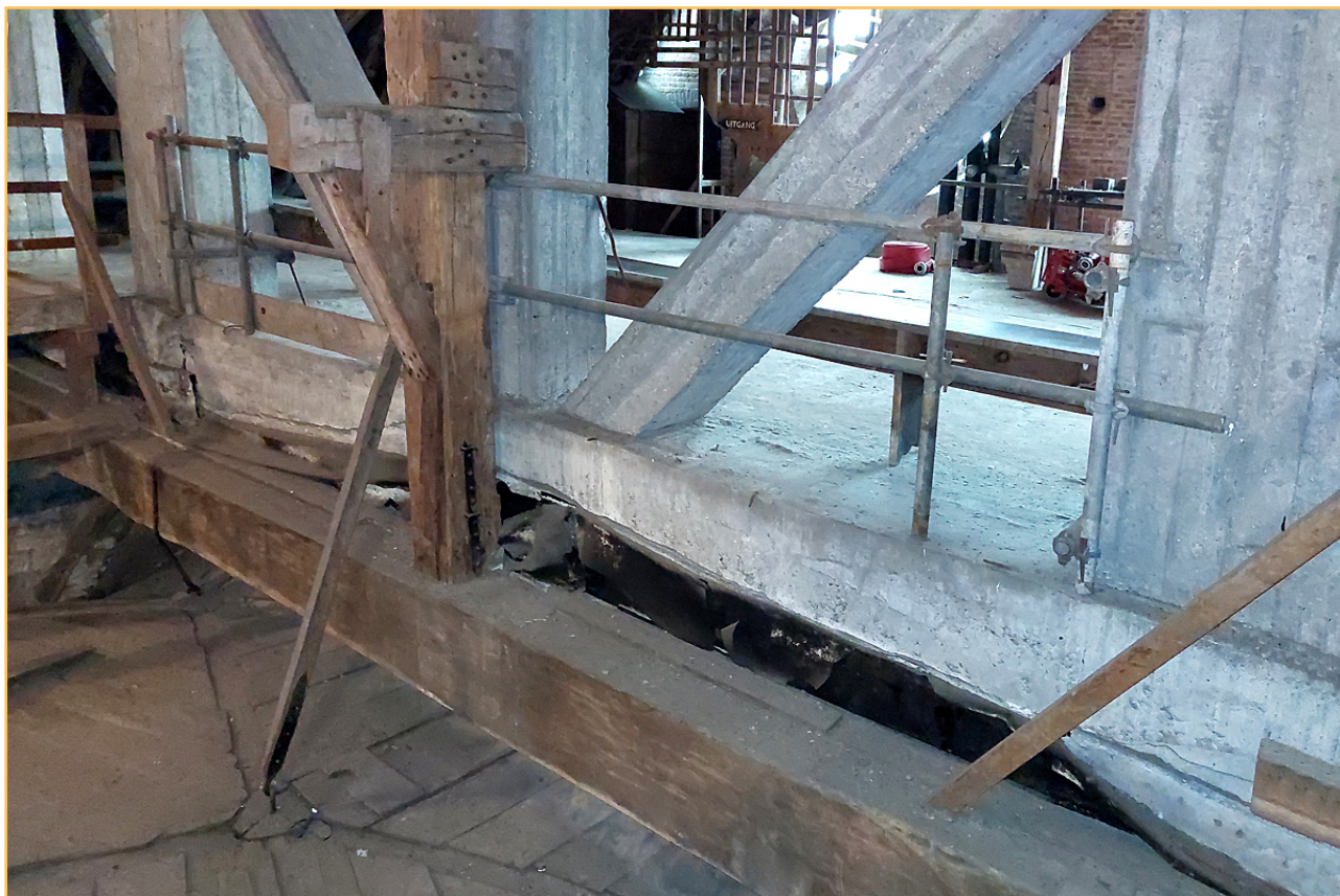
Het spant met zicht op het gewelf en de betonnen plaat
