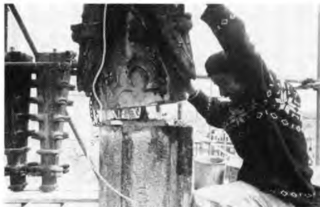
Het plaatsen van een pinakelstuk.
