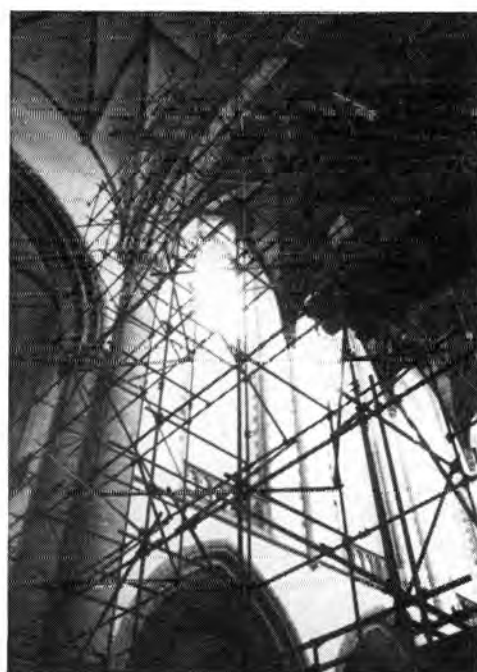
9) verplaatsing steigers naar het schipgedeelte
