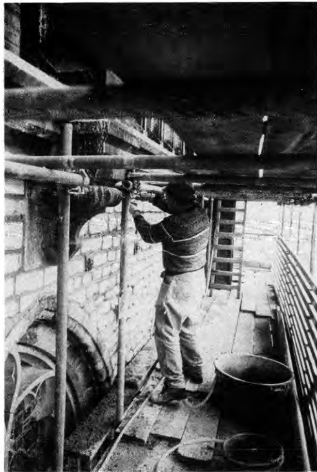
de steenvoeger aan het werk Zuider Transept.
