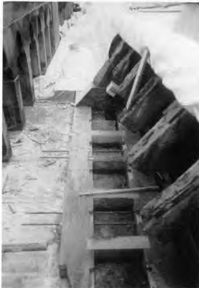
Vernieuwde kapvoetconstructie
