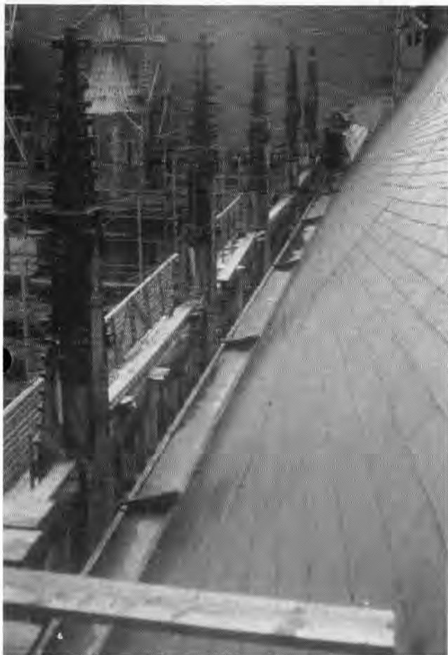
Nieuwe koperen dakgoot
