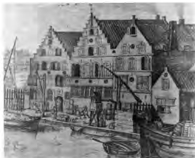
Detail van het schilderij "De Bierbrouwerij de Drie Leliën en het buiten Velserend" door Jacob Matham, nl. de bierbrouwerij. Ongeveer over het midden van de foto loopt horizontaal de naad, waar de plank had losgelaten; de onderste ramen van het middelste huis 'kloppen' niet meer! Linksboven is in de lucht een kras herkenbaar en in het water een paar vuile strepen.
